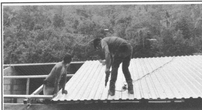
Foto 3: Se observa el techado de la cocina.
