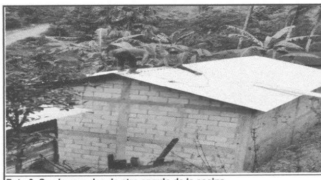
Foto 6: Se observa desde otro ángulo de la cocina.
